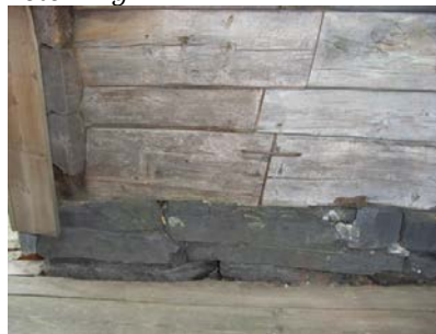
Bindhake over skråskjøtt bunnstokk laft i Midthuset i Jakobsfjorden. Trolig fra 1960-tallet.
