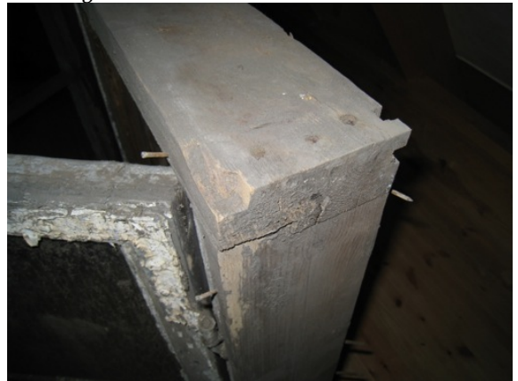
Vinduskarm sikret med tre stykk blank trådstift. Skuteviksboder 14. Vindu fra 1920.
