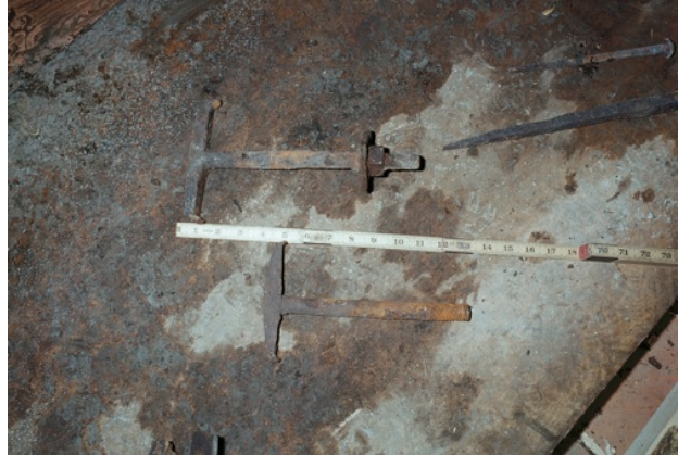
Klobolter funnet i Svensgården rom 4C101. Her er en bolt med mutter. Skriftlig dokumentasjon mangler. Ser ut som sekskantmutter. Kanskje fra reparasjonene i 1948?
