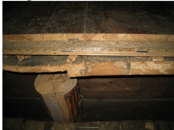
Skjult spikring av pløyd bordgulv 5B401, med blank (rusten) trådstift. Oppforet gulv fra 1979.
