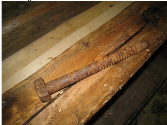
Fransk skrue med firkanthode fra nyere opplenger i Skuteviksboder 11. Sannsynligvis fra 1920-tallet.
