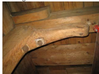
Skuteviksboder 14. Kne festet med skrubolter både med firkanthode og sekskanthode. Fra ombygging i 1920.
