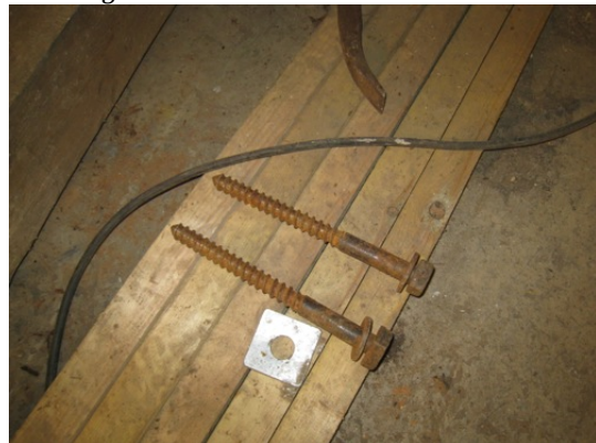
Franske skrue med firkanthode demontert for gjenbruk i Skuteviksboder 15. Fra en omfattende byggemeldt ombygging nettopp fullført i 1920.
